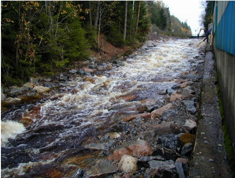
Figur 3. Exempel på hur en mer naturlig botten kan återskapas med höga krav på släntstabilitet. Sten och block gör det möjligt för fiskar att hitta ståndplatser och få skydd. Exemplet är från Sörån i Bollebygd. Foto: Robert Versa.
