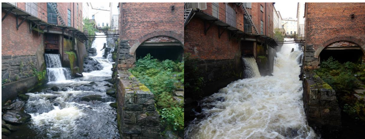
Figur 1. Nedre delen av fallet i Kvarnbyn. Vänstra fotot visar fallet vid ett flöde på ca 500 l/s. På bilden syns tydligt den branta lutningen och bottenstrukturen bestående av häll. Högra fotot visar fallet vid högre vattenföring och hur vattnet "kastas" ut över berghällar.
