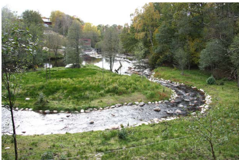
Omlöp vid Bosgårdens kraftverk i Rolfsåns åtgärdsområde. Foto: Markus Lundgren.
